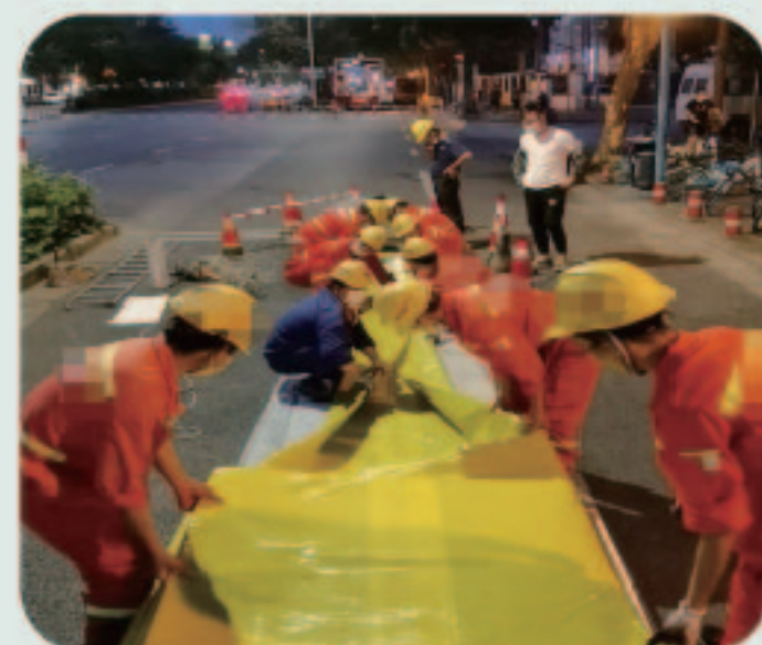
材料拉出后3等分平折， 底部铺垫底模保护材料
