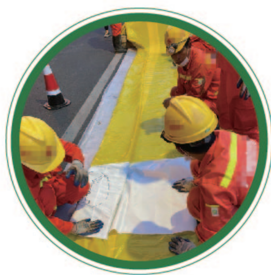
将材料拉出起始端套入扎头布3等 分折叠进行捆扎绑头工作
