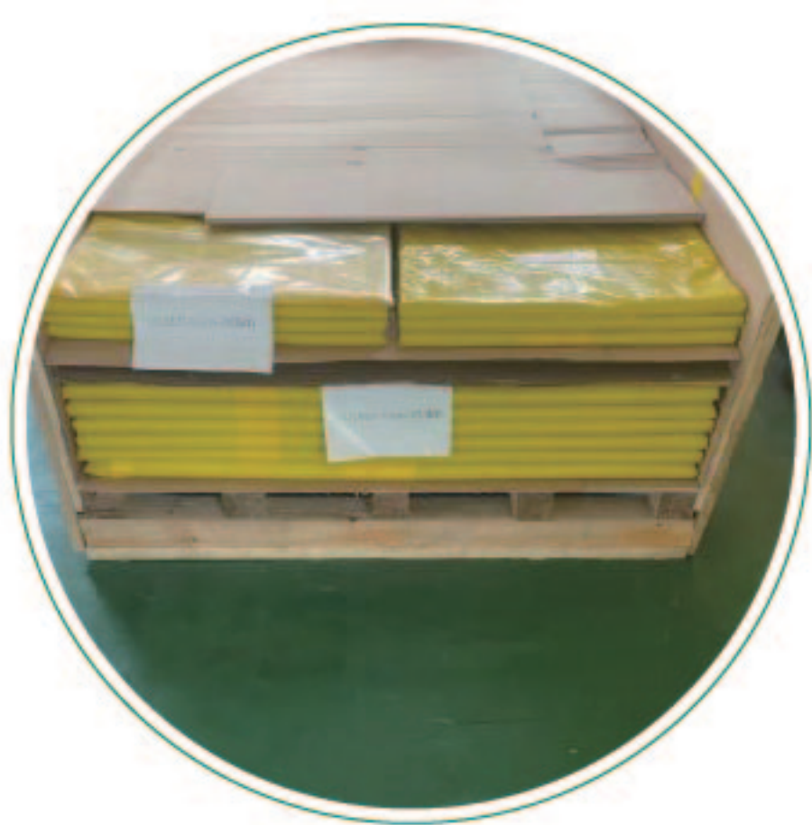
盖板拆除， 取出装箱单及其他辅料
