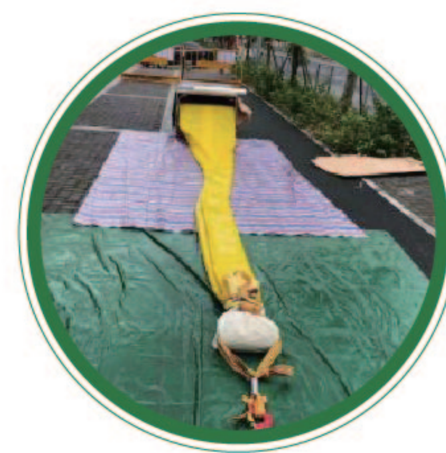
捆扎时扎头布套在折叠部位 且包裹绑扣收紧位置的材料
