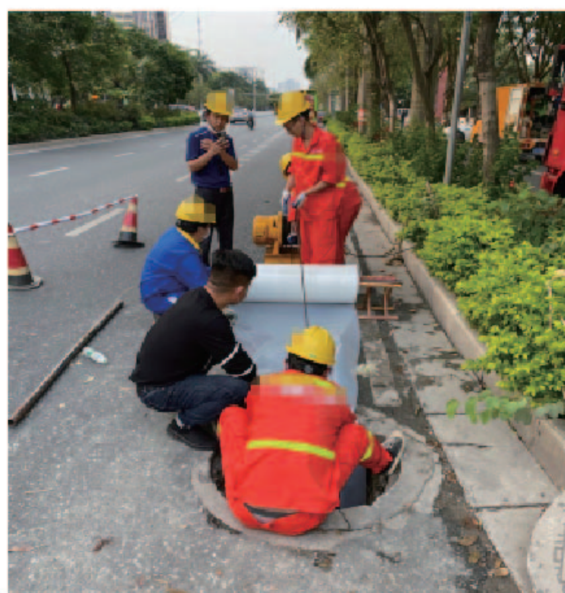
管内铺垫底膜， 将钢丝绳放于底膜上一起拉入井内
