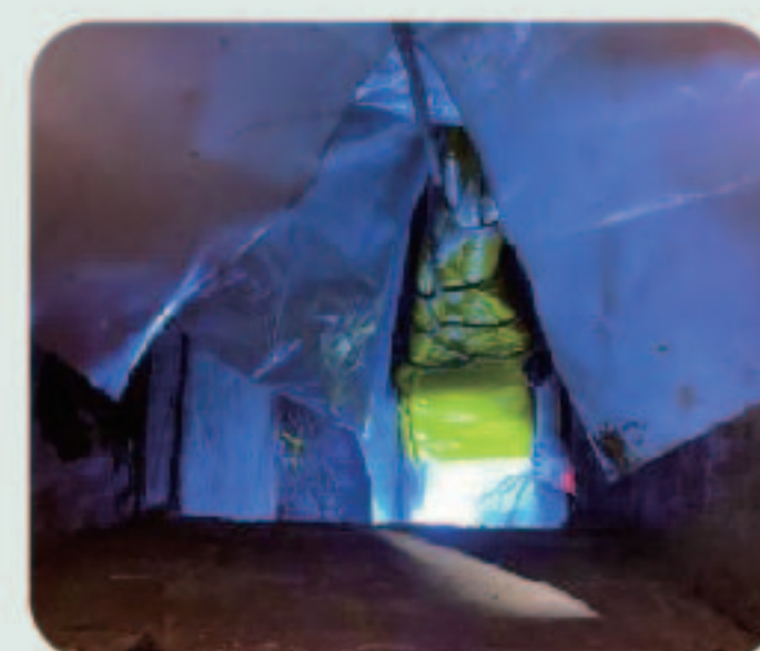
尾部材料须用绳子 绑紧缓慢放入井内
