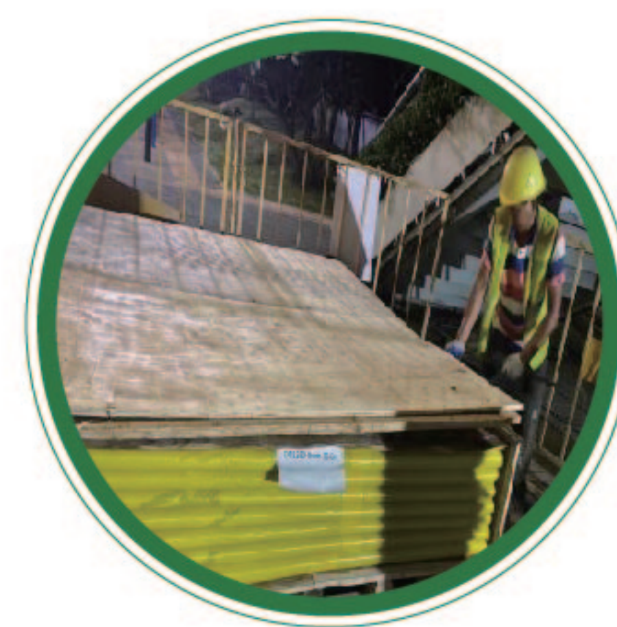
井口于木箱前铺垫底模，再拆下料口 挡板，拆卸挡板时，须注意箱内材 料，小心钉子
