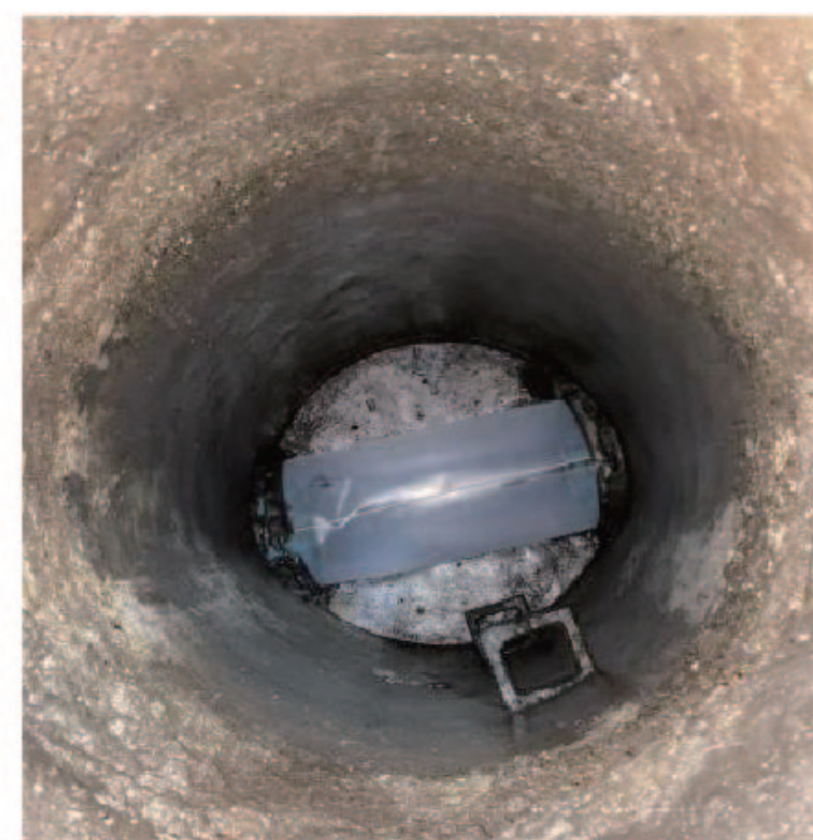
底膜是平整铺于管底且钢丝绳位于底膜中间
